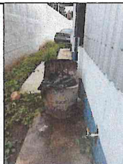
Foto 6: Estado actual de cocina
